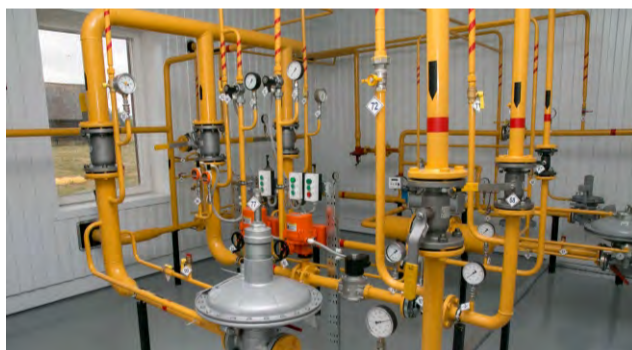
Технологическое оборудование ГРП учебного полигона
