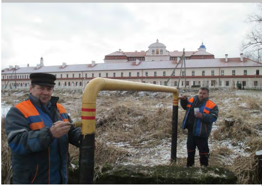
Слесари СОРНГГО Пасюк С.Е., Баран В.И. проводят ТО и покраску переходов через водные преграды вблизи Свято-Успенского Жировичского монастыря.
