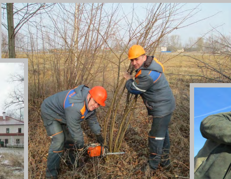
Слесари СОРНГГО Жодь Д.В. и Павловский С.В. проводят очистку трассы газопроводов.
