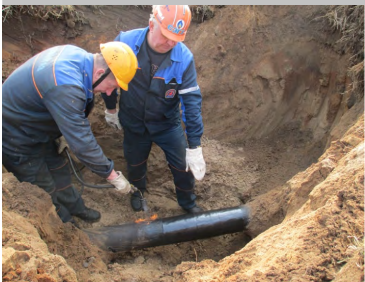
Слесари СОРНГГО Шпак В.А. и Скурат М.М. устраняют обнаруженные повреждения изоляции при КПО.
