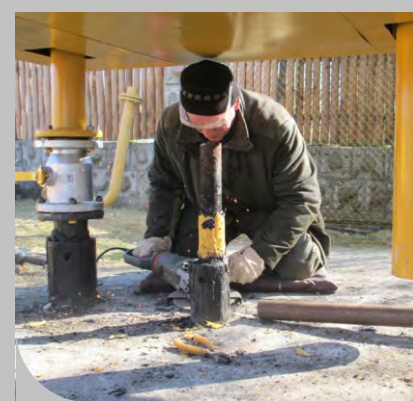
Бригада СОРНГГО проводит замену ШРП.
