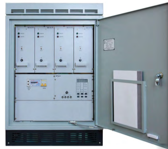
Станция катодной защиты
